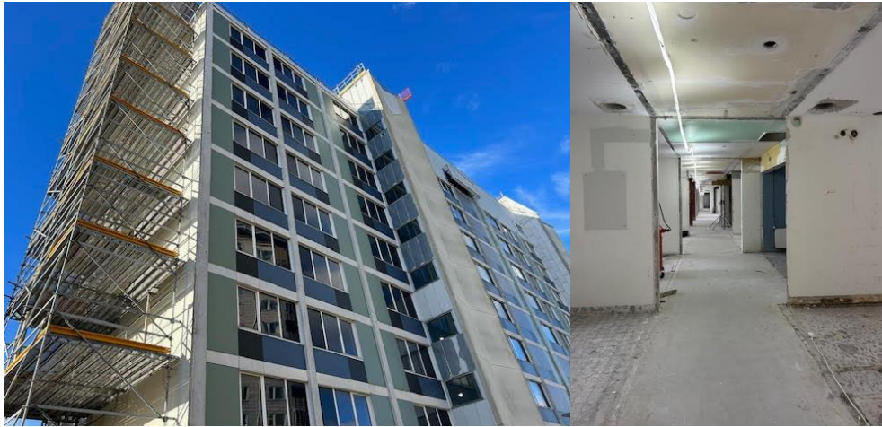
Figur 9. Pågående konvertering av byggnaden. Bilder av Brinova.
